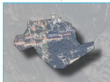
Technopole de l'Arbois (Aix-en-Provence, 13) : Zone incendie, Technopole à dominante de services tertiaires supérieurs.
